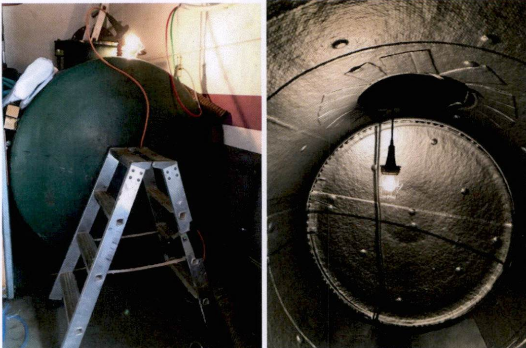
Abbildung 1: oberirdischer Stahltank - Einbau der Leckschutzauskleidung
